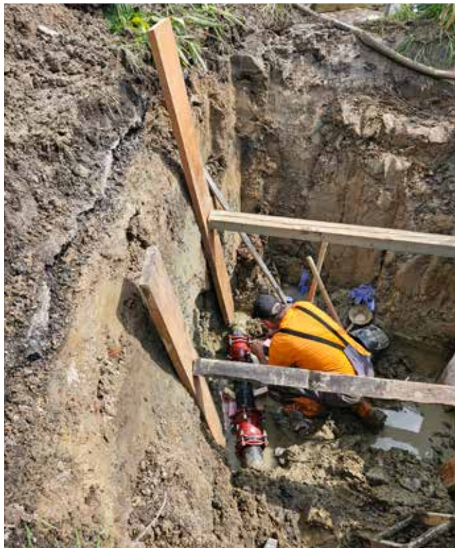
Arbeiten an Wasserleitung in Altaist
