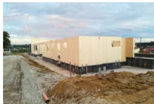
Baustelle Krabbelstube Katsdorf
